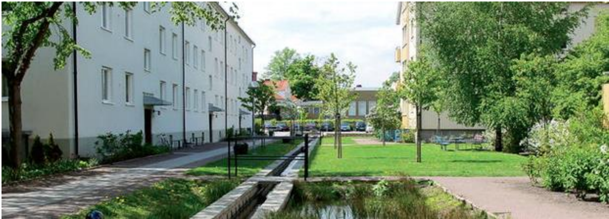
Figure 1 : Eco-quartier Augustenborg à Malmö
